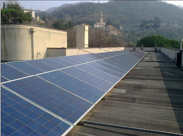
fotovoltaici. Questi sono lastre formate da diversi strati; la parte superiore è di colore blu ed è formata da celle che trattengono una parte di energia solare, che in seguito diverrà energia elettrica.
